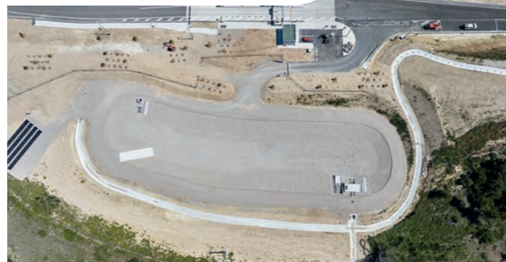
Bassin sur la bretelle d'entrée.
