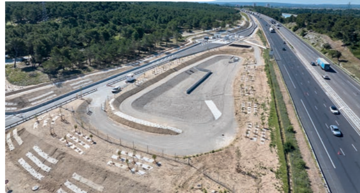
Bassin sur la bretelle de sortie.
